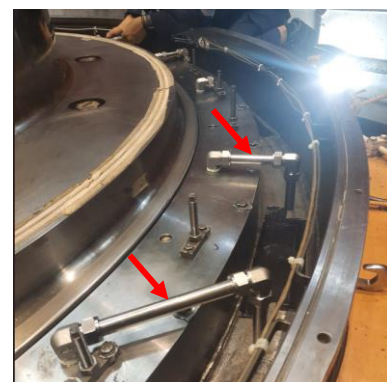
Gambar 9 Modifikasi Sistem Sirkulasi Pelumas
